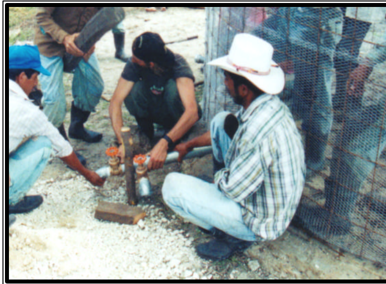
Colocacion de tubos de entrada y salida de agua
