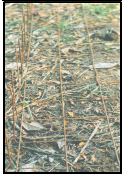
Doblez de la electromalla a 90 grados
