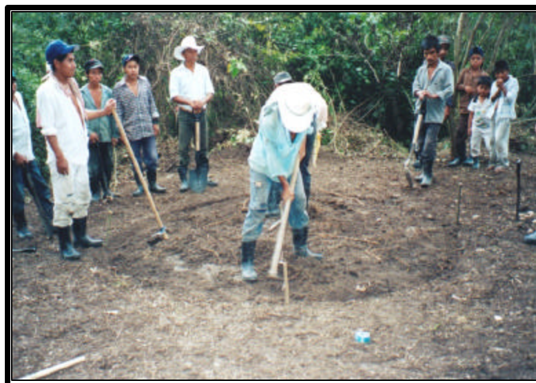
Excavacion de la cimentacion
