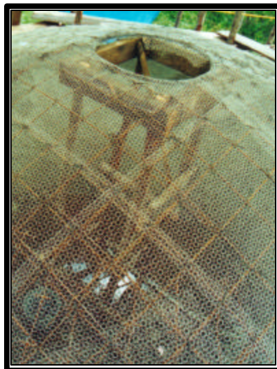
Torre al centro del tanque
