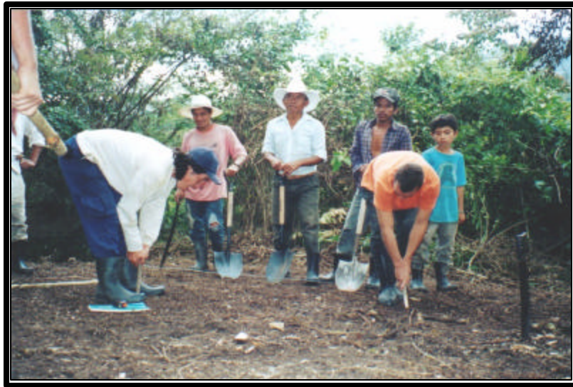
Trazo de la Base de la Cimentacion.
