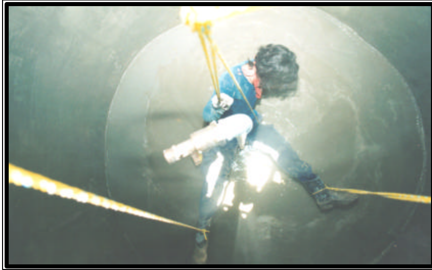
Acabado del piso del tanque
