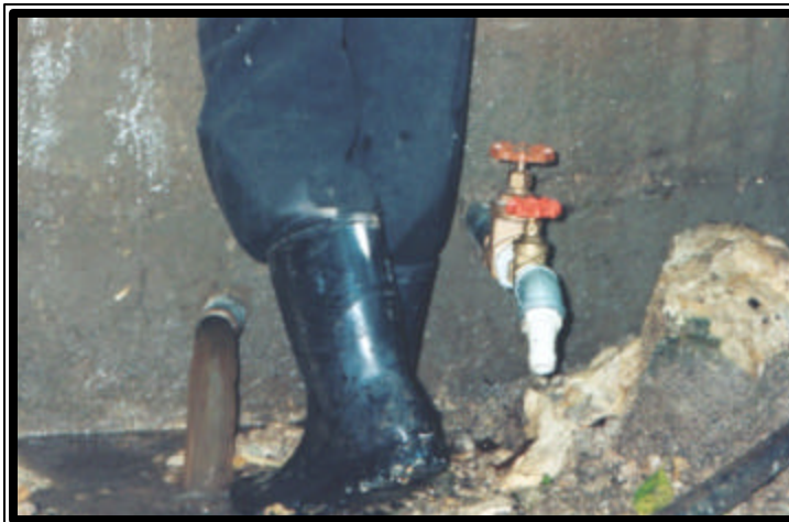
Limpieza del tanque
