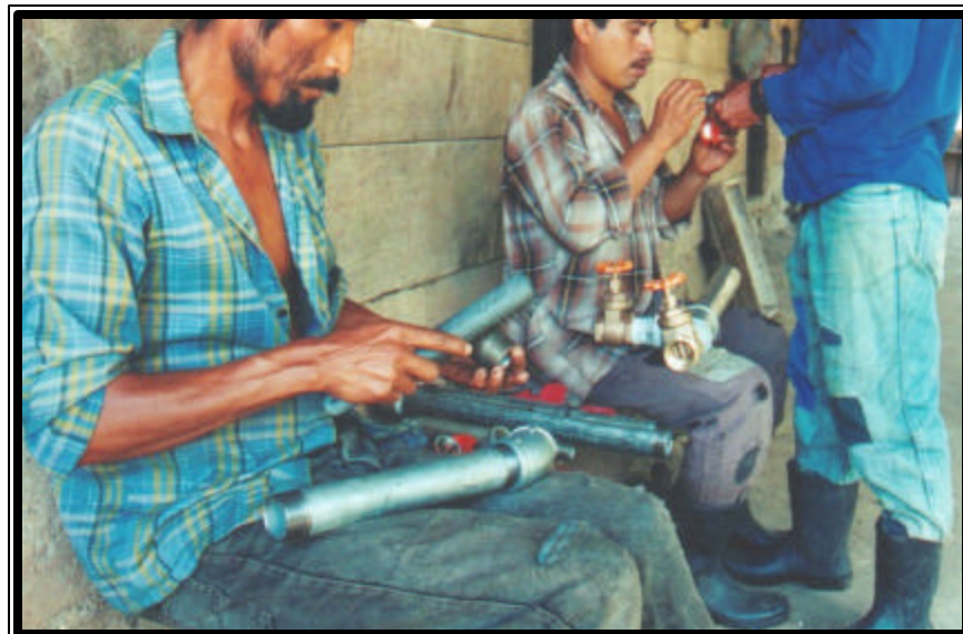
Armado de la tuberia
