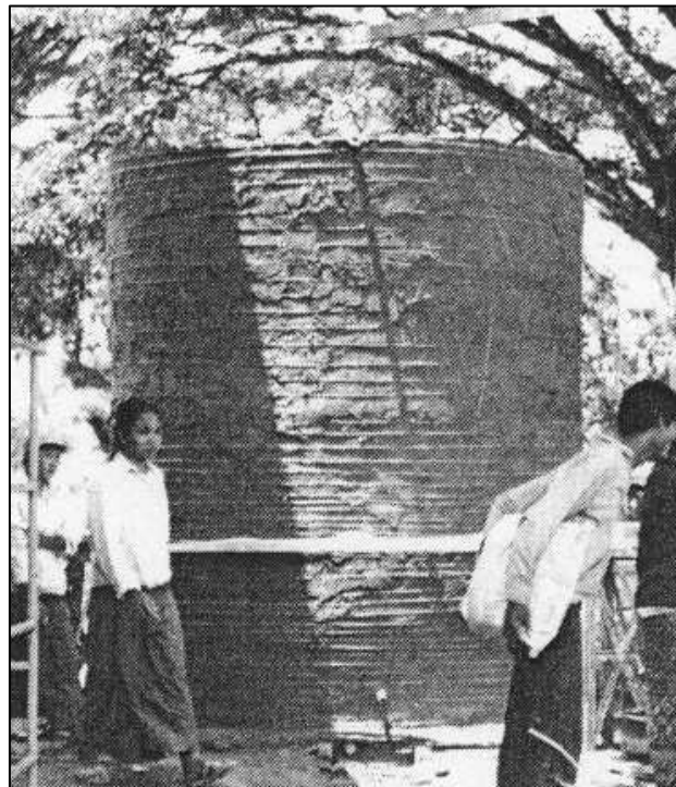
Figura 4. Tanque de Almacenamiento
